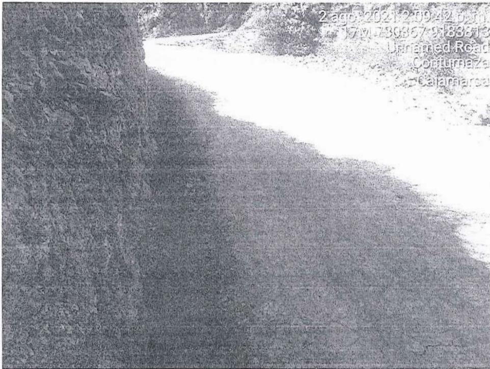
**FOTO N° 03:** Se puede evidenciar que la cuneta no se encuentra colmatada.
